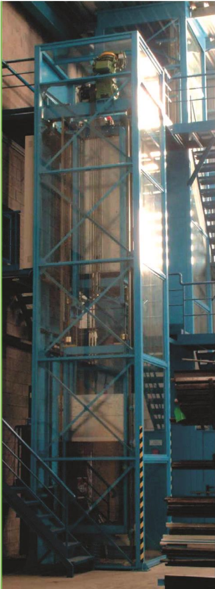
Tracción eléctrica sin sala de máquinas. Doble embarque 90°. Electric roomless. Double boarding 90°.
