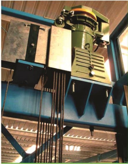
Tracción eléctrica sin sala de máquinas. Doble embarque 180°. Electric roomless. Double boarding 180°.
